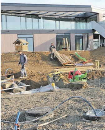
Im Horner Baugebiet »Segeten« entsteht derzeit die neue Kindertagesstätte »Seestern«. Im Januar soll der Neubau eingeweiht werden. swb-Bild: pud
