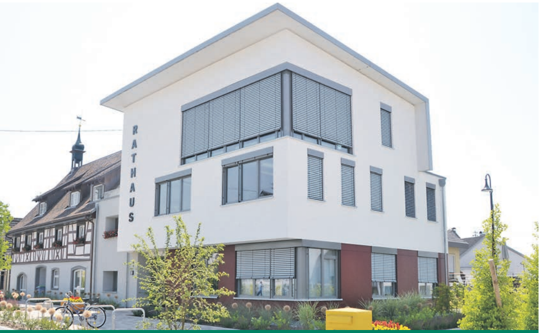
Das Rathaus Eigeltingen in der Krumme Straße wird nach Sanierung und Fertigstellung des Anbaus am Samstag, 25. Juli, mit einem Tag der offenen Tür eingeweiht.swb-Bild: sw
