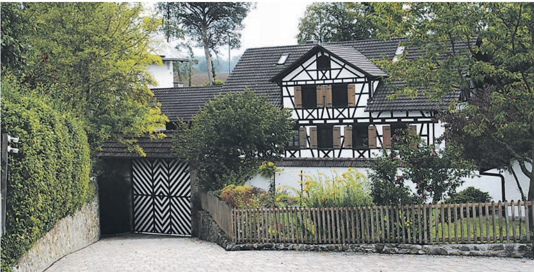
Das Gailinger Hofgut Lochmühle soll mit zusätzlichen Wohnungen und kleine Gewerbeeinheiten umgebaut werden.
