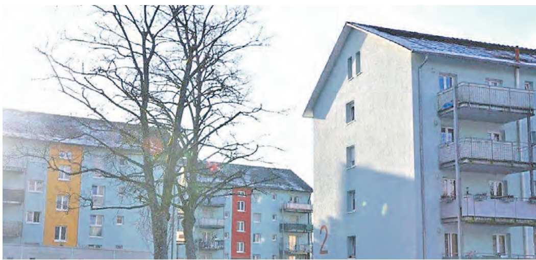
Die 460 Sozialwohnungen der GVV, wie beispielsweise diese im »Langenrain«, suchen einen neuen Eigentümer. Die Stadt Singen wird es offensichtlich nicht sein, stattdessen wird ein Investor gesucht, der Wohn- und Gewerbeimmobilien im Gesamtpaket erwirbt.
