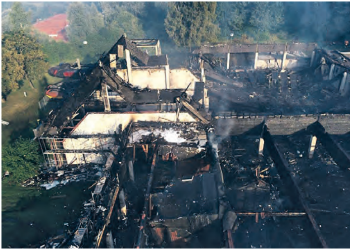
Nur ein Trümmerhaufen blieb vom Schwaketenbad übrig, das am Samstag komplett abbrannte. Für Konstanz entstand ein enormer Schaden.
