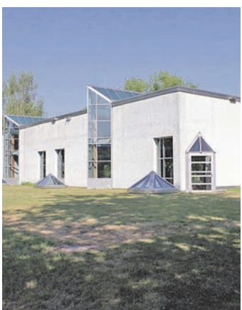
Neben der neuen Leichtbauhalle in Radolfzell soll die Kreissporthalle in Singen ab September als Flüchtlingsunterkunft genutzt werden. swb-Bild: of
