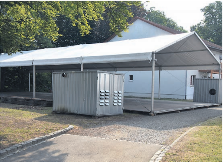
Noch ist die neue Leichtbauhalle in Radolfzell nicht fertig, doch bereits ab September soll sie Platz für rund 100 weitere Flüchtlinge bieten.
