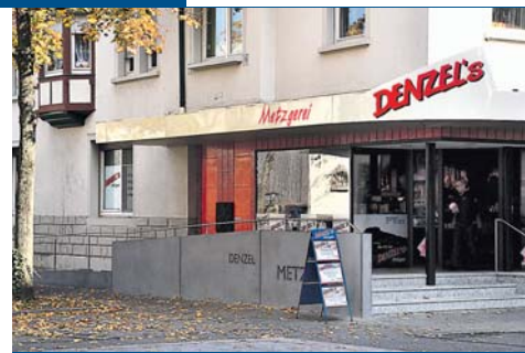
Mit der Rampe (links) können nun auch ältere Kunden problemlos sogar mit Rollator oder Rollstuhl in der Metzgerei Denzel ihre Einkäufe erledigen.
