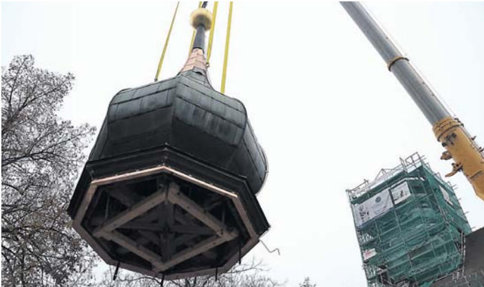
Sie schwebt in Richtung Turm: die drei Tonnen schwere Zwiebel wurde zentimetergenau auf den Turm gesetzt. Weitere Fotos finden Sie unter bilder.wochenblatt.net . swb-Bild: mu
