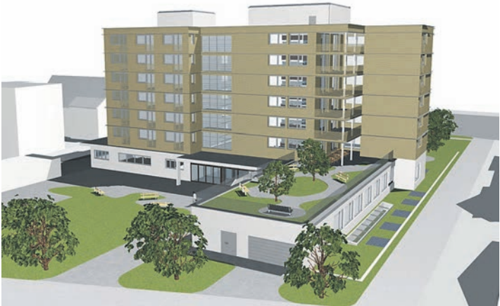
Bis zum April 2018 wird das Alterswohnheim Thayngen zur Baustelle. Noch ist das künftige Antlitz des Gebäudekomplexes nur eine Planung.
