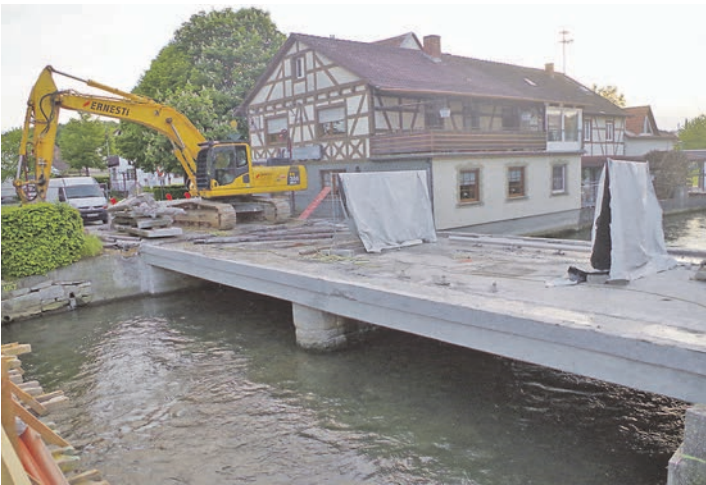
Gleich nach dem Radrennen in Volkertshausen haben die Bauarbeiten für den Ersatz der zwei Aachbrücken in der Ortsmitte begonnen. swb-Bild: of
