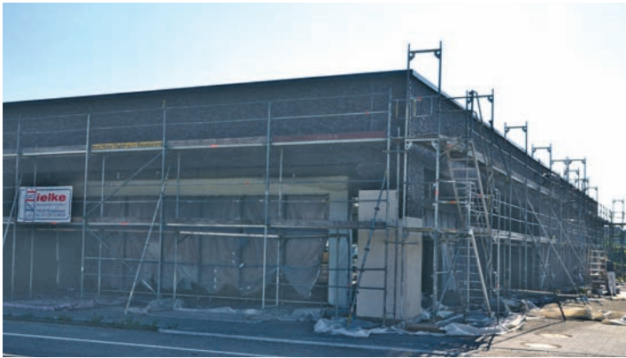
Die Arbeiten an der Außenfassade des neuen Münchow-Marktes im Rielasinger Gewerbegebiet sind soweit abgeschlossen, ab letzter Woche begann der Innenausbau. swb-Bild: stm
