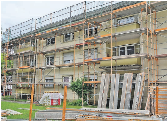
Die »Deutsche Annington« hat die energetische Modernisierungsmaßnahmen in der Bahnhofsstraße, Kreuzensteinstraße und Hegaustraße gestartet, die bis zum Jahresende abgeschlossen sein sollen.
