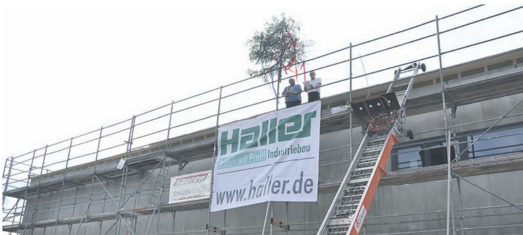
Am Samstag wurde Richtfest beim Feuerwehrgerätehaus in Beuren gefeiert.
