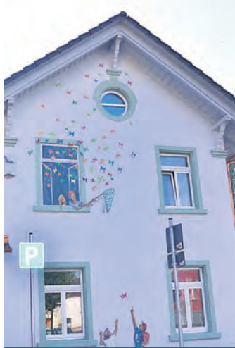
Das alte Wohngebäude der Ordensschwestern wird für den Kindergarten umgebaut.
