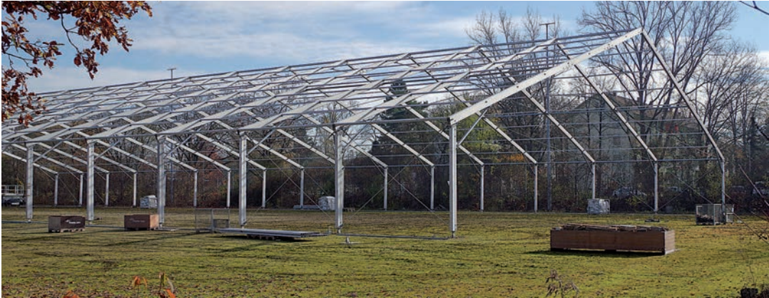
Schon weit fortgeschritten sind die Aufbauarbeiten für eine Leichtbauhalle aus dem ehemaligen Kunst-rasenplatz beim Hohentwielstadion in Singen.
