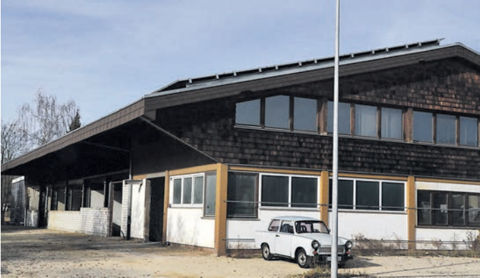
Nach umfangreichen Umbauarbeiten könnte diese Lagerhalle in der Byk-Gulden-Straße als Unterkunft für 180 Flüchtlinge dienen.
