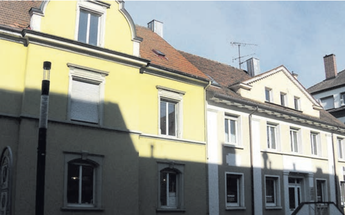
Durch Abriss der historischen Gebäude soll in der Hadwigstraße 13/15 der Neubau eines Wohn- und Geschäftshauses erfolgen.
