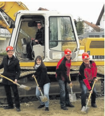
OBwald-Wohnbau realisiert ein Neubauprojekt in Steißlingen. swb-Bild: rab
