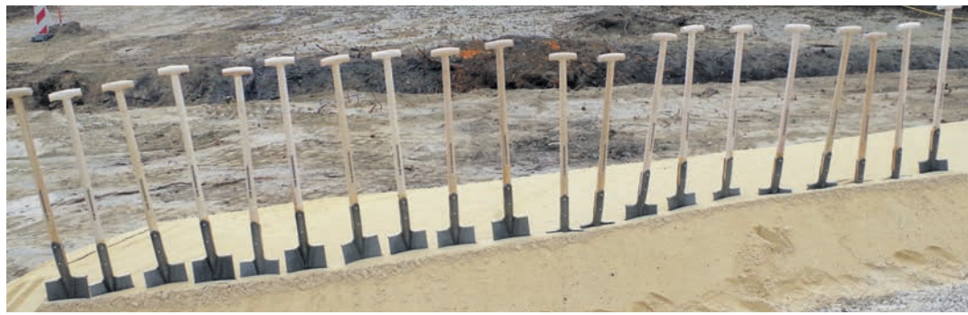
Viele Spaten gingen in 2015 zu offiziellen Baustarts in die Erde, freilich brauchte auch jeder Spaten jemanden, der ihn in die Hand genommen hat.
