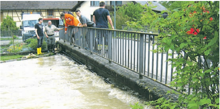
In Wahlwies stieg das Hochwasser gegen Mittag stark an und drohte die Brücke zu überspülen. swb-Bild: fw
