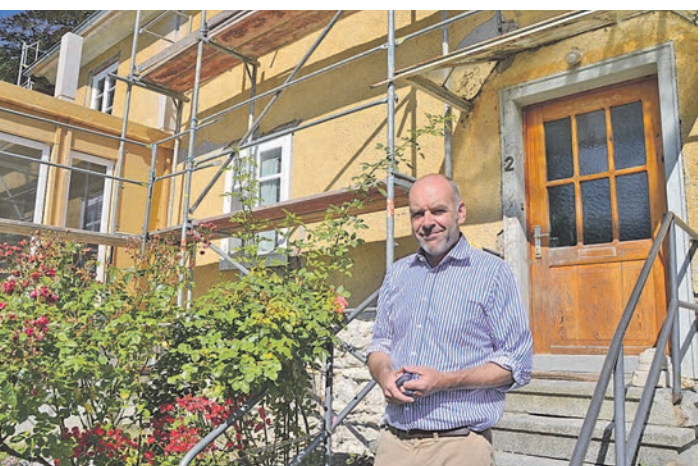
Die Sanierung des Gärtnerhauses neben dem Gräflichen Schloss in Bodman ist ein Bauprojekt von Architekt Tobias Jaklin.
