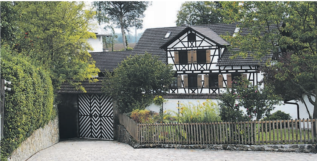
Das Gailing Hofgut Lochmühle soll mit zusätzlichen Wohnungen und kleine Gewerbeeinheiten umgebaut werden.
