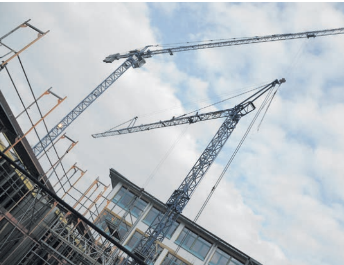
Der Neubau für den Schulverbund Nellenburg ist eines der kommunalpolitischen Großprojekte 2016 in Stockach. swb-Bild: sw
