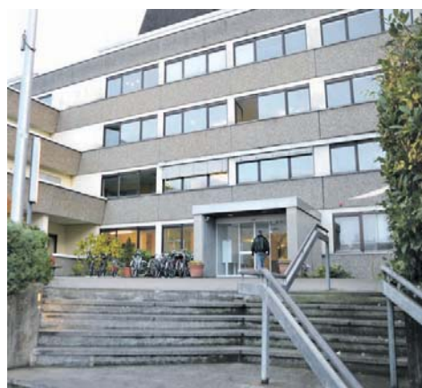
In der Gemeinschaftsunterkunft in der Zoznegger Straße in Stockach könnten künftig bis zu 300 Flüchtlinge untergebracht werden. Der Kreis prüft die brandschutzrechtlichen Bedingungen für eine Erhöhung der Belegungszahlen. sub-Bild: sw
