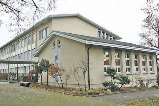
Noch immer ist offen, was aus der alten Lettenhalle wird. Die Schulgemeinde pocht auf Abriss.
