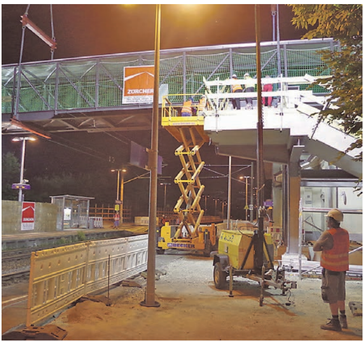
Erst im zweiten Anlauf konnte die Brücke über den Gottmadinger Bahnhof an der richtigen Stelle platziert werden. Dadurch gingen die Arbeiten über zwei Stunden länger als geplant in der Nacht auf Samstag. swb-Bild: of
