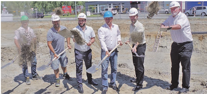
Kurz nach dem Baubeginn konnte am letzten Mittwoch der offizielle erste Spatenstich für die neue Tankstelle in Gottmadingen vollzogen werden.
