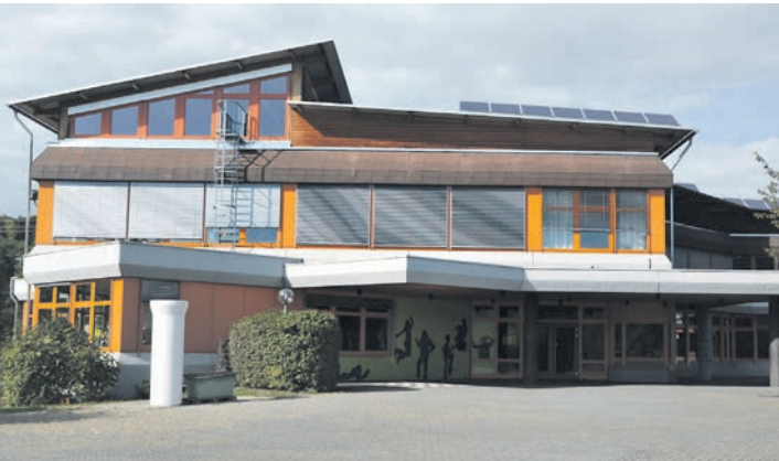
Die naturwissenschaftlichen Räume der Gemeinshaftsschule Eigeltingen werden an- und umgebaut. swb-Bild: sw
