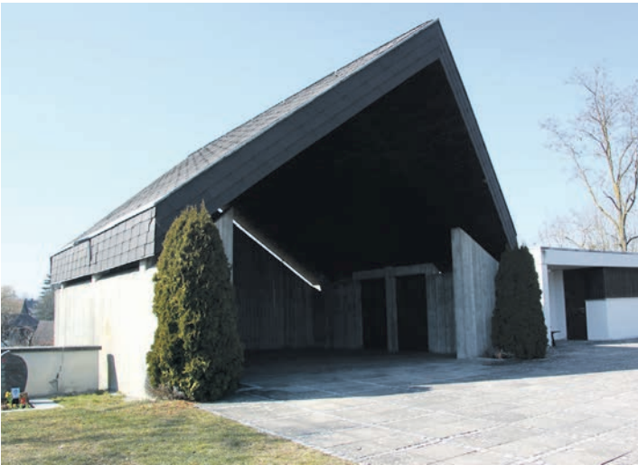
Die Aussegnungshalle in Orsingen wird saniert. swb-Bild: sw
