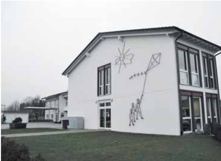
Der Anbau an die Grundschule in Nenzingen soll in den Pfingstferien starten.
