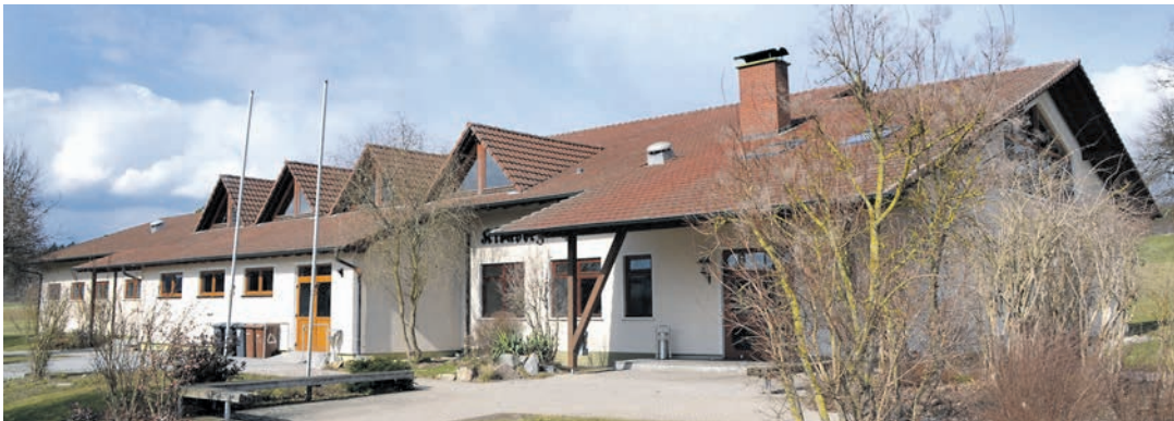
Auf die Sanierung der Kirnberghalle in Orsingen wurde 2015 verzichtet. Auch ein Grund, warum von den geplanten 2,33 Millionen an Investitionen nur 1,6 Millionen Euro ausgegeben wurden.swb-Bild: sw
