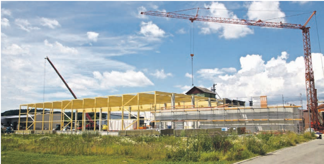
Der Bioweinspezialist Peter Riegel setzt bereits den dritten Erweiterungsbau im Industriegebiet von Orsingen-Nenzingen um.
