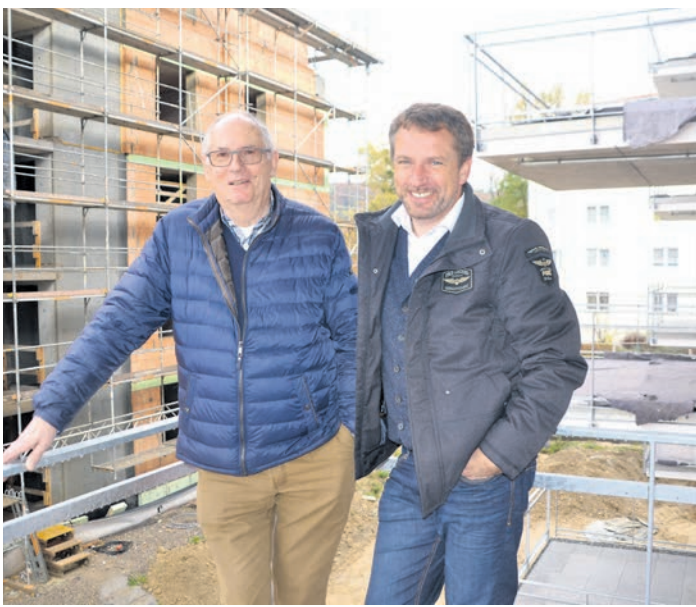
Ehrgeizige Pläne: Im Gewinn »Galgenäcker« denken Dieter Fritz und Roland Mathis (rechts) neben den bereits im Bau befindlichen beiden Häusern über zwei weitere Gebäude nach. swb-Bild: sw
