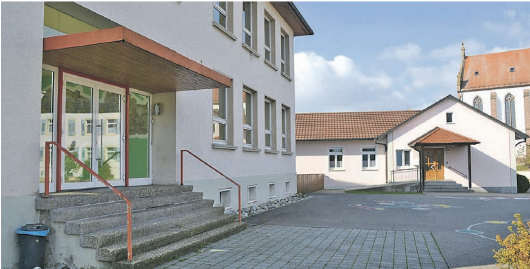
Der Kindergarten in Orsingen bei der Schule soll einen Anbau bekommen. Um mehr Fläche zu erhalten, könnte das nicht mehr genutzte Schulgebäude abgerissen werden. swb-Bild: sw
