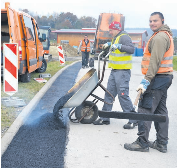
Drazen Pavlovic, Danjel Pesut und Josip Davidovic (v.l.) von der Firma A-Tec teeren im Eigeltinger Gewerbegebiet die Trassen, in denen die neuen Internetkabel liegen.
