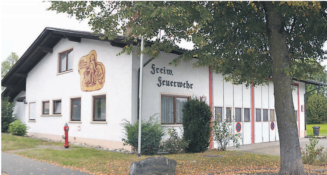
Das Feuerwehrgerätehaus in Orsingen wird nach Plänen des Gemeinderats umgebaut. swb-Bild: sw
