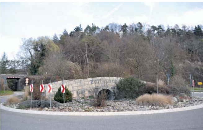
(oben) Musste aus Sicherheitsgründen abgebaut werden: der Aufbau des Kreisels »Zollbruck« am Ortseingang von Nenzingen.
