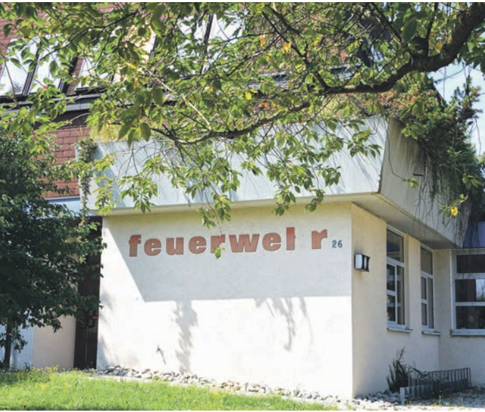
Das derzeitige Feuerwehrhaus könnte bald ausgedient haben: Laut Feuerwehrbedarfsplan, den der Radolfzeller Gemeinderat jüngst verabschiedet hat, gilt der Bau eines neuen Feuerwehrhauses in der Kernstadt als eine der wichtigsten Zukunftsinvestitionen der Feuerwehr.
