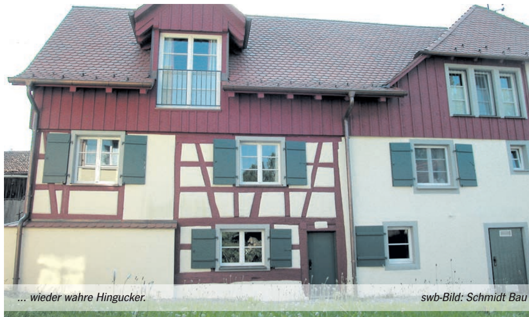
Die Firma »Schmidt Bau« aus Öhningen hat sich auf die Sanierung und Restaurierung von Altbauten spezialisiert. Mit viel Können und Leidenschaft werden aus sanierungsbedürftigen Gebäuden...
