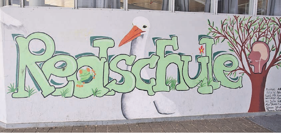
Der Zahn der Zeit nagt an der Gerhard-Thielke-Realschule in Radolfzell – nun forderten einige Stadträte, dass die Verwaltung ihre Pläne zum Umbau der Einrichtung zügig umsetzen solle. swb-Bild: rab
