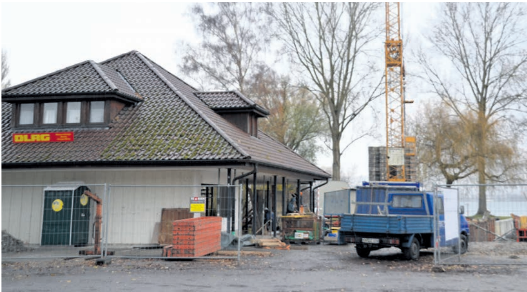
Der Mooser Haushalt für 2017 wird von zwei Großprojekten bestimmt: Zum einen ist dies die neue Sporthalle, die in der Höri-Gemeinde gebaut werden soll, und zum anderen die Sanierung des Strandbades in Iznang, an dem die Arbeiten bereits laufen.
