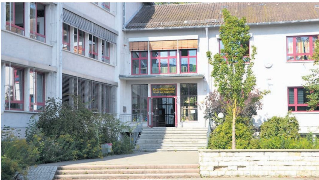
Mit der Gemeinschaftsschule und dem Vorhaben an der Realschule gilt es zwei Schulmaßnahmen parallel zu stemmen.
