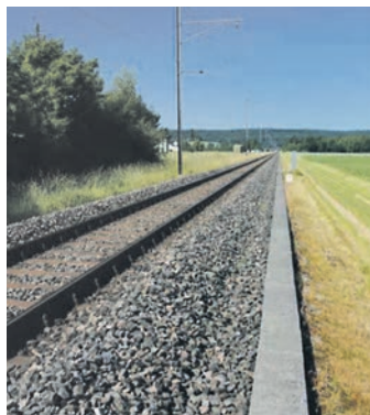
An der Bahnstrecke zwischen Diessenhofen und Schaffhausen wird ein 1,4 Kilometer langer Abschnitt zweigleisig ausgebaut. swb-Bild: Jungi
