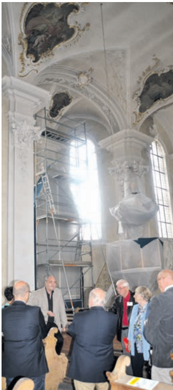
Die aufwendigen Stuckarbeiten in der St. Peter und Paul Kirche brauchen mehr Zeit.
