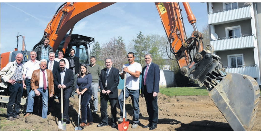
Spatenstich für das WBG-Mehrfamilienhaus im Kornblumenweg, im Bild die WBG-Aufsichtsräte mit Vera Federer, dem hauptamtlichen Vorstand (vorne rechts), daneben Aufsichtsratsvorsitzender Bürgermeister Klinger und ganz rechts, Wilhelm Knapp, nebenamtlicher Vorstand.
