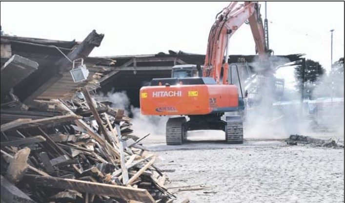
Jetzt geht es den Güterhallen endgültig an den Kragen: Nachdem in den vergangenen Wochen die Entkernungsarbeiten im Inneren schon im vollen Gange waren, rückte das Abbruchunternehmen »Schotter-Teufel« jüngst mit schwerem Gerät an. Die ehemalige Güterhalle sowie die Kantine werden in Vorbereitung für die Seetorquerung vollständig rückgebaut, damit auf der frei werdenden Fläche die Baustelle für das Bauvorhaben eingerichtet werden kann.
