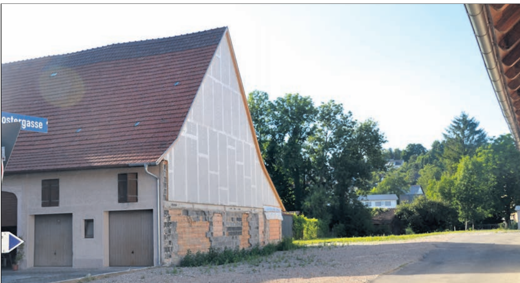
Bald rücken die Baumaschinen an: In seiner jüngsten Sitzung hat der Hilzinger Gemeinderat mehrheitlich beschlossen, für die Entwürfe des »Koch Planungsbüros« aus Moos für die Bebauung der Klostergasse grünes Licht zu geben. Die OBwald Wohnbau GmbH sowie die Dr. Lang Group, die sich ebenfalls für das Areal interessiert hatten, zogen im September ihre Bewerbung zurück. Die Pläne des Architekten Benjamin Koch sehen dabei die Errichtung von zwei Mehrfamilienhäusern mit jeweils sieben Wohneinheiten im oberen Preissegment sowie ein drittes Gebäude am Dorfplatz mit einem integrierten Café vor. Die Erschließung soll über die Klostergasse erfolgen. swb-Bild: Archiv/mu
