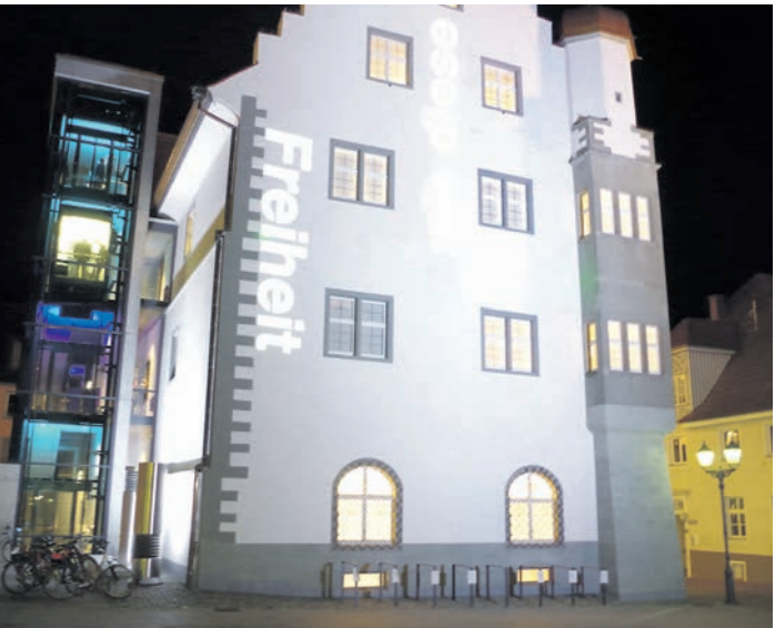
Die erste Bilanz der Stadtbibliothek nach den Sanierungsarbeiten am »Österreichischen Schlösschen« liest sich fulminant: Allein bei der Kulturnacht kamen 3.000 Besucher in das Radolfzeller Kleinod auf dem Marktplatz.
