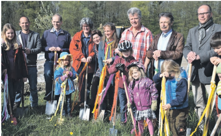
Gemeinsam mit OB-Stellvertreter Norbert Lumbe, Baudirektor Thomas Nöken und Geschäftsführer Alfons Krismann packten die Kinder der Unterseeschule beim Spatenstich zum Neubau in der Nordendstraße ordentlich mit an.
