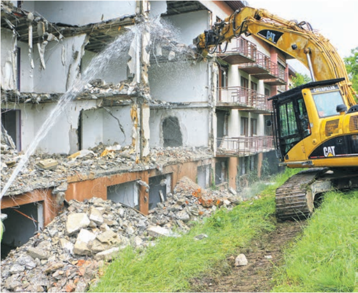
Derzeit wird das ehemalige Schwesternwohnheim auf der Mettnau abgerissen. An seiner Stelle soll in Zukunft ein neues Pflegeheim entstehen.
