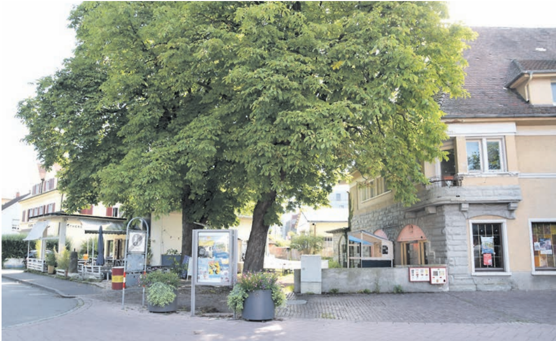
Sie müssen bald einer modernen Bebauung weichen: Die Szene-Kneipe »Tanke« und der ehemalige Gasthof »Schützen« auf dem Schützenareal. Der Investor, die Firma »Gnädinger & Mayer«, plant ein moder-nes Gebäudeensemble auf diesem Bereich.
