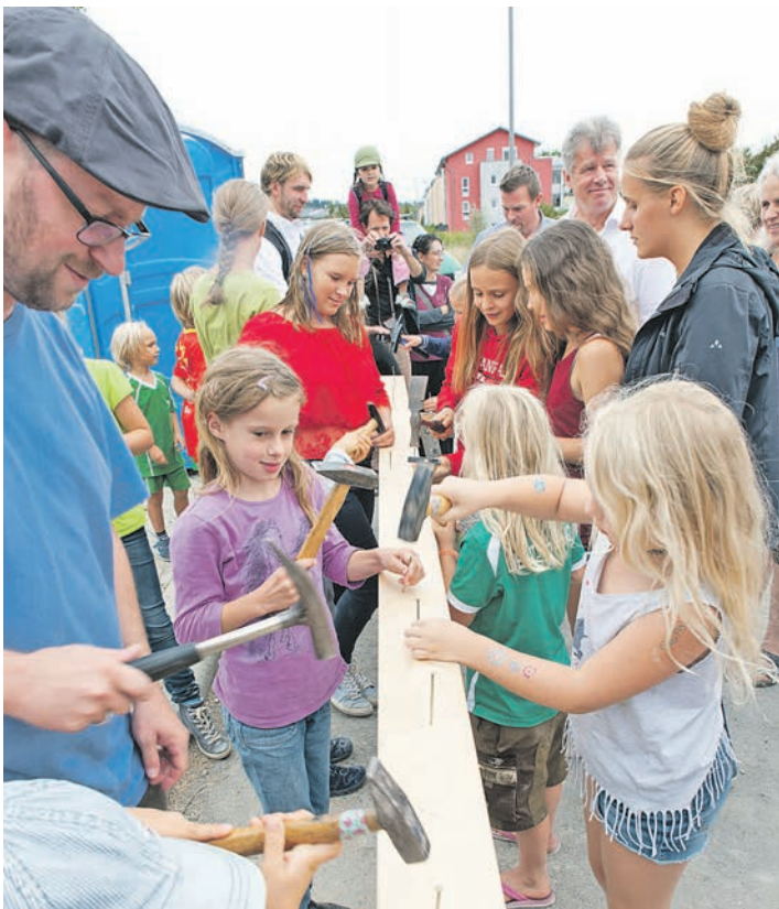
Richtfest an der neuen Unterseeschule samt Kindergarten in der vergangenen Woche. Statt des letzten Nagels wurden dann gleich siebzig goldene Nägel eingeschlagen: von allen Kindern, Erzieherinnen, Lehrern und Gästen.
